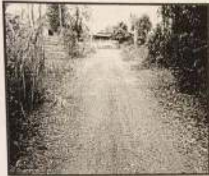
ก่อสร้างถนนคอนกรีตเสริมเหล็ก หมู่ที่ ๖ บ้านสำโรง
